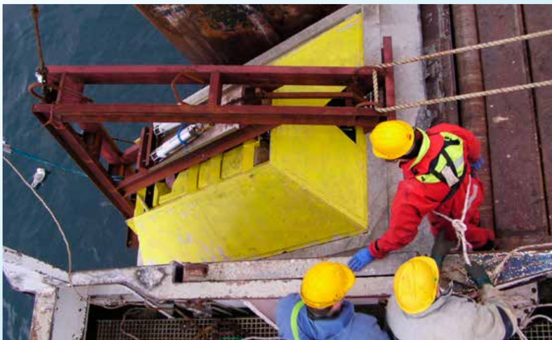
Mynd 2. Ein streymmátari verður loraður niður á botn frá Magnusi Heinasyni. Hann skal máta ferðina á Føroyastreyminum og er væl vardur móti troli.
