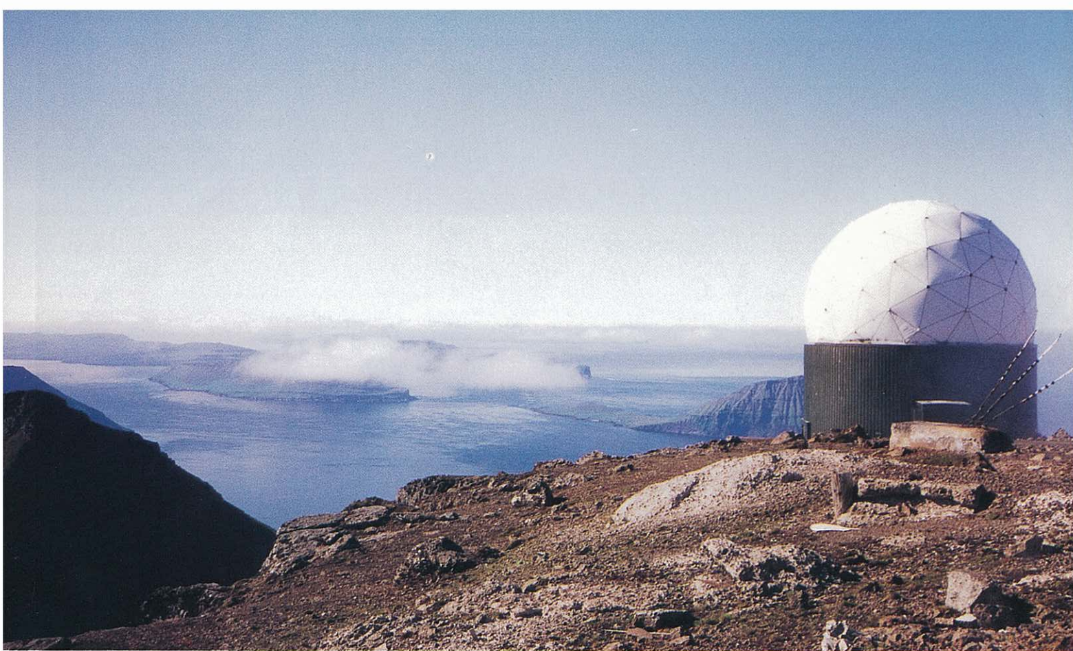
Ein av radome-kúpunum uppi á Sornfelli
